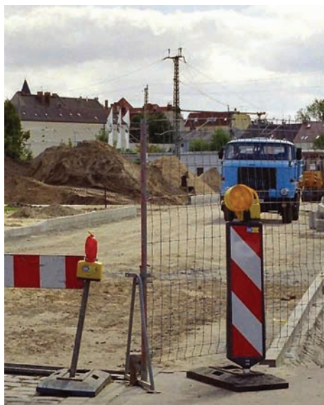
Autos auf der neuen P+R-Fläche den Tag über abstellen können. Eine Mittel-Insel
